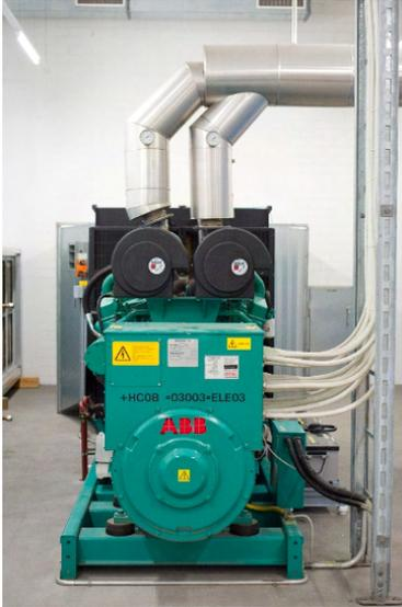
Mit einem leichten Schmunzeln auf dem Gesicht gehen wir weiter in einen Raum, der mit einem grossen Tank und einem mintgrünem Dieselgenerator ausgestattet ist. «Was denkt ihr, ist am Notstrom angeschlossen?» werden wir gefragt. Auch wenn der Generator stattlich wirkt und ihm rund 6'500 Liter Diesel zur Verfügung stehen, werden wir skeptisch, denn im Vergleich zu allen anderen Anlagen wirkt er unbedeutend. Der Generator liefere gerade genug Strom, um die Aufzüge in Brandposition zu brin-
